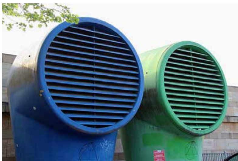
5600 Neue Staatsgalerie Stuttgart, Detail © Fred Romero cw
