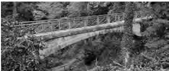
Karlshöhe, Brücke über dem ehem. Steinbruch
