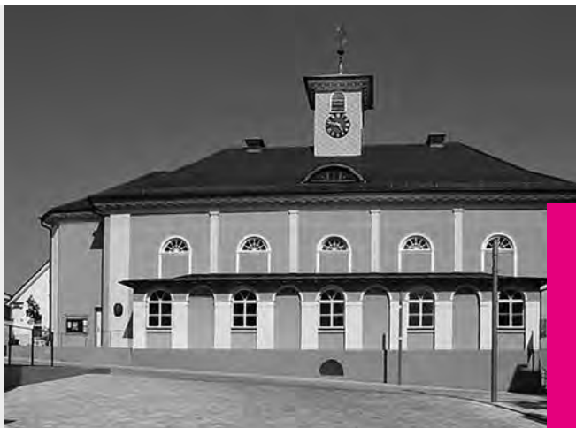
Großer Betsaal der Brüdergemeinde Korntal
